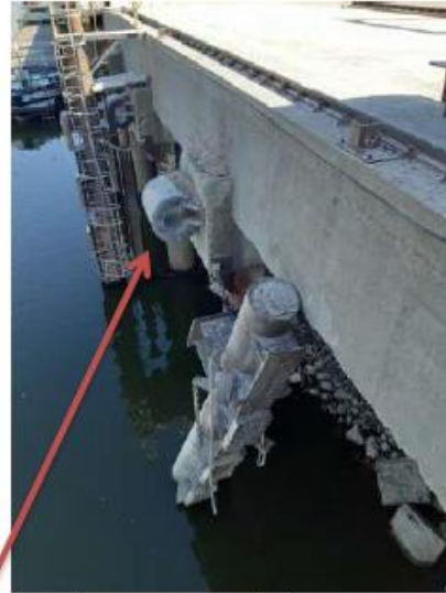
Позиција за уградњу одбојне/фендерске конструкције са два носача - Тип „А“
