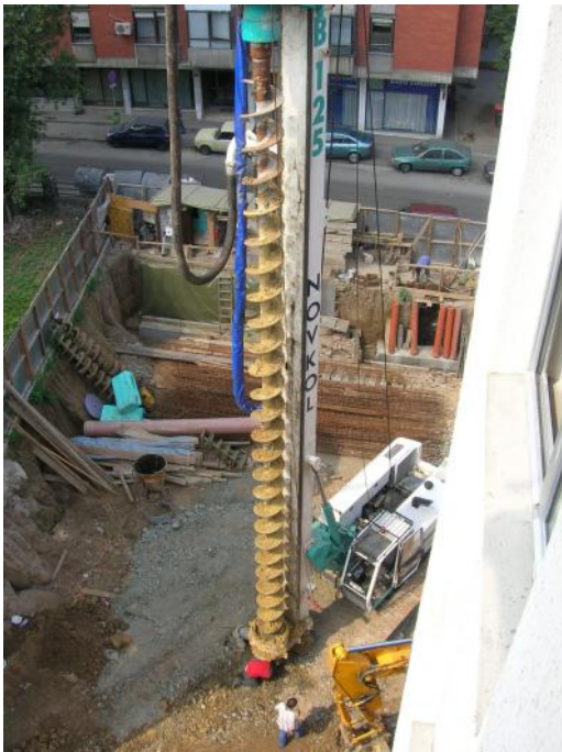
Слика 42 CFA систем за бушење и инсталацију шипова
