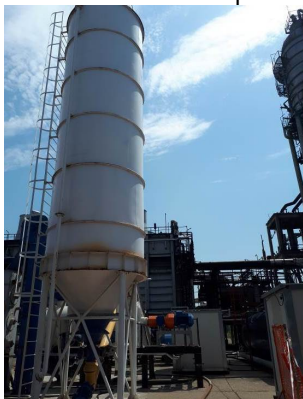
Slika 15. Silos sa krečom
