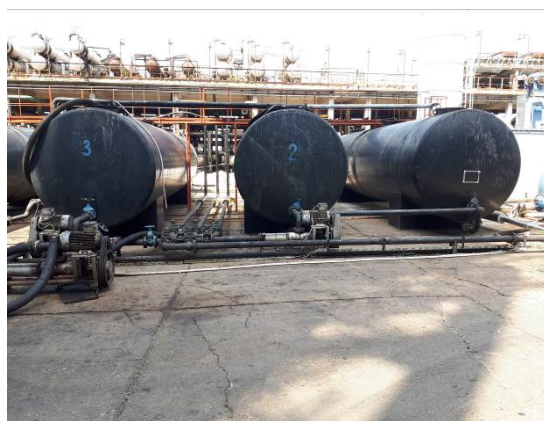
Slika 5. Procesni rezervoari 1, 2 i 3 za ulazni tok
