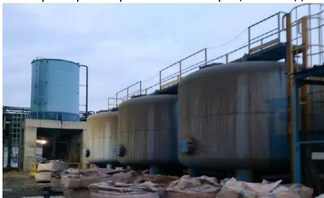
Слика 6.4.3. – Филтери за пречишћавање процесних вода
