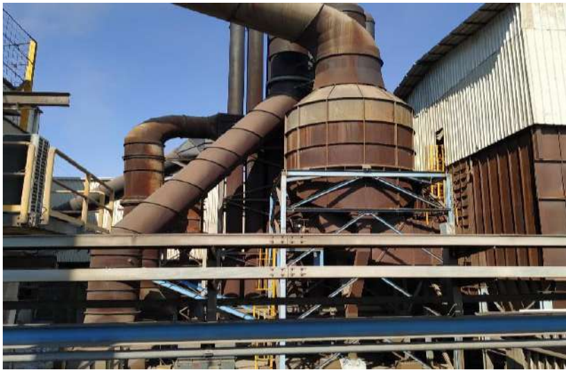
Слика 6.3.2.– Центрифугални сепаратор
