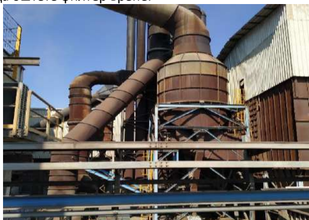
Слика 7 – Центрифугални сепаратор
