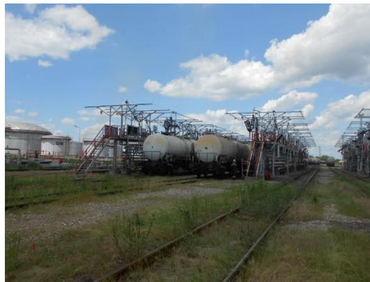
Slika 15. Železničko pretakalište S-24100
