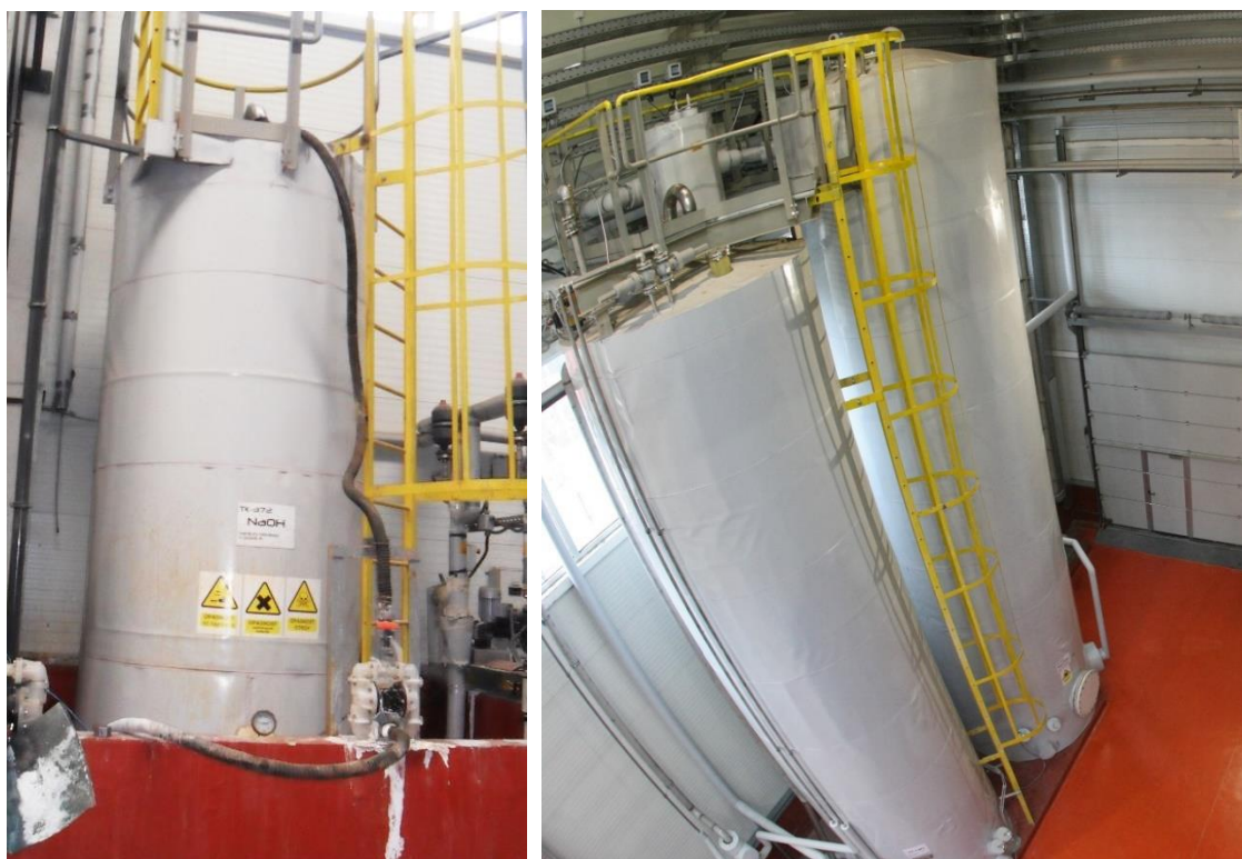
Резервоар натријум хидроксида (лево) и натријум сулфида (десно)
