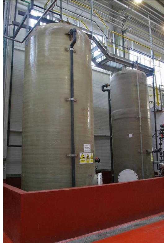
Танк за сакупљени електролит (лево), Резервоар сумпорне киселине (десно)
