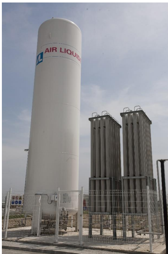
Слика 9. Резервоари за течни кисеоник
