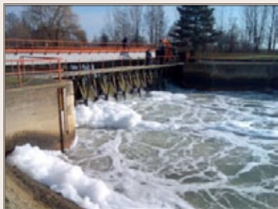
Изглед Пловног Бегеја на устави Итебеј. Појава пене као знак загађења површински активним материјама
